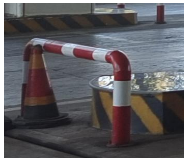
图 17 加油岛防撞栏杆
