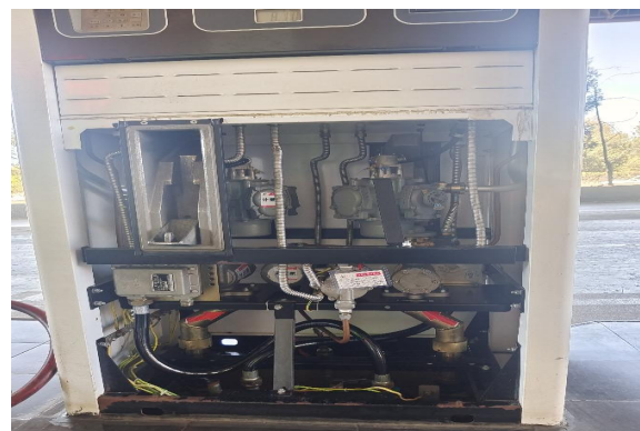
图 6 加油机内部
