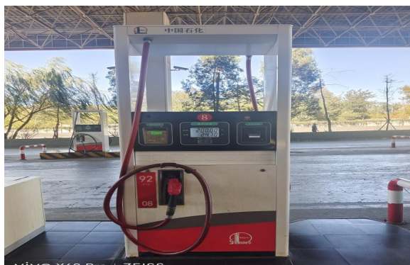
图 5 汽油加油机
